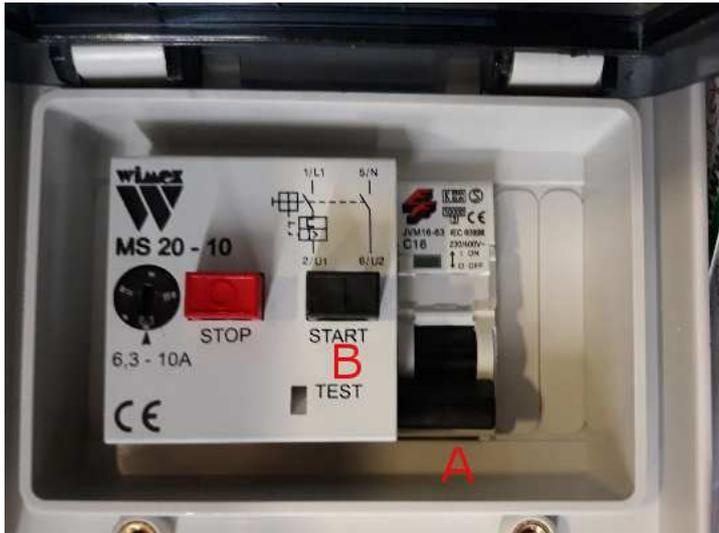
L'interruttore B comanda il motore del nastro sul quale è montata la scatola, l'interruttore A comanda il motore del nastro successivo.
